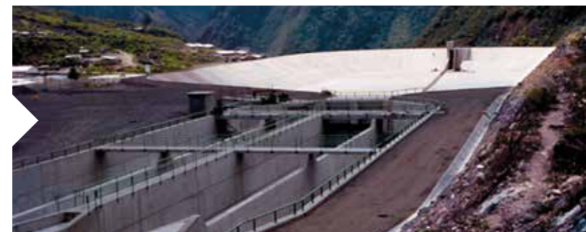
Central hidroeléctrica San Gabán, Puno
