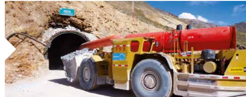
Túnel Rampa 4400, Mínera Sayumarca. Paucar, Ayacucho
