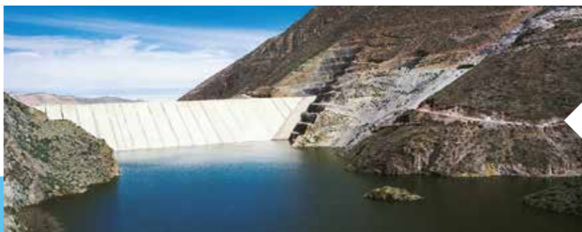
Presa del río Torata, Moquegua
